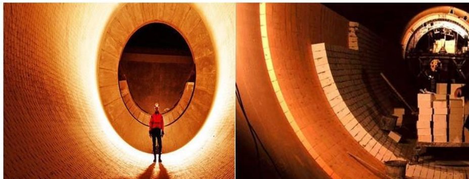
Figure I. 9 : Briquetage dans le four rotatif de cimenterie.
