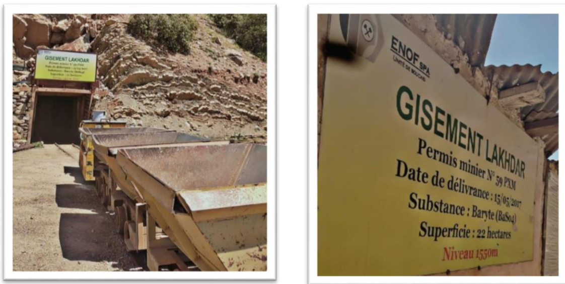
Figure 15 - Portail d'accès et infrastructures principales du gisement de Lakhdar.
