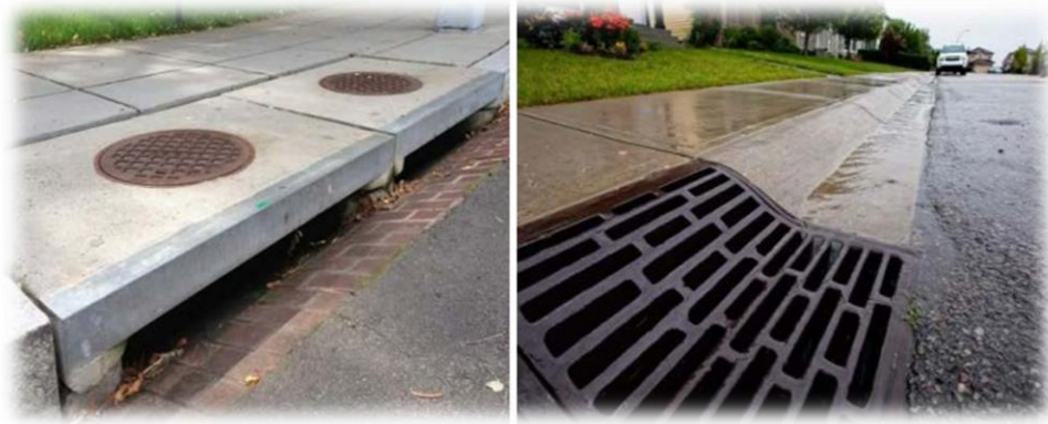
Figure I. 7: Bouche d'égout (El Wavi & Nouioua, K., 2022)
