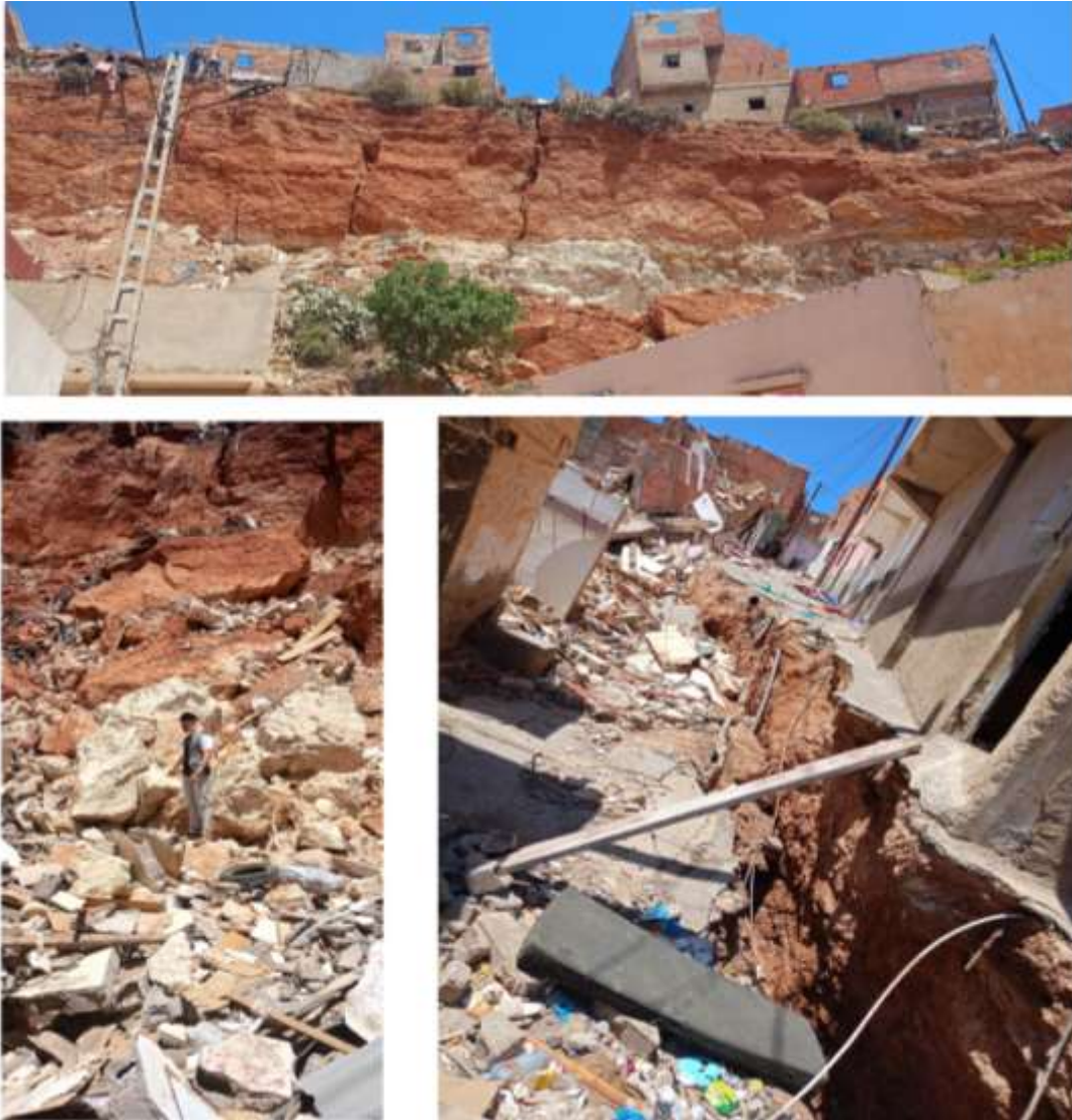
Figure 33 : l'effondrement du site de Chaabat planteur
