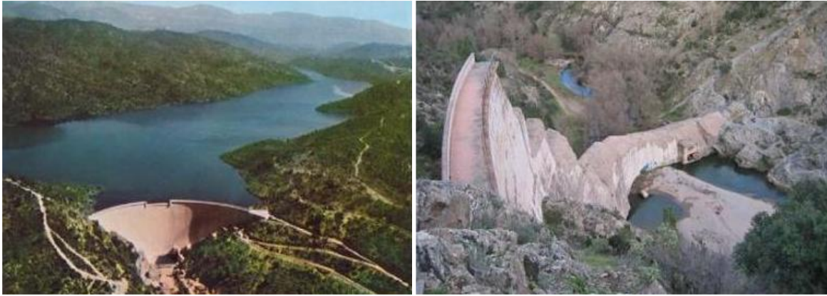
Figure N° I.1 : Le barrage de Mal passé avant et après sa rupture
