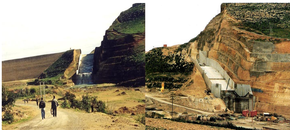
Figure N° II.11 : L'évacuateur de crues du Barrage de Gar-Gar.
