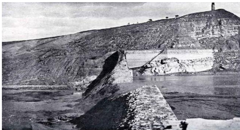
Figure N° I.4 : Vue du barrage Fergoug après la rupture du 25 novembre 1927
