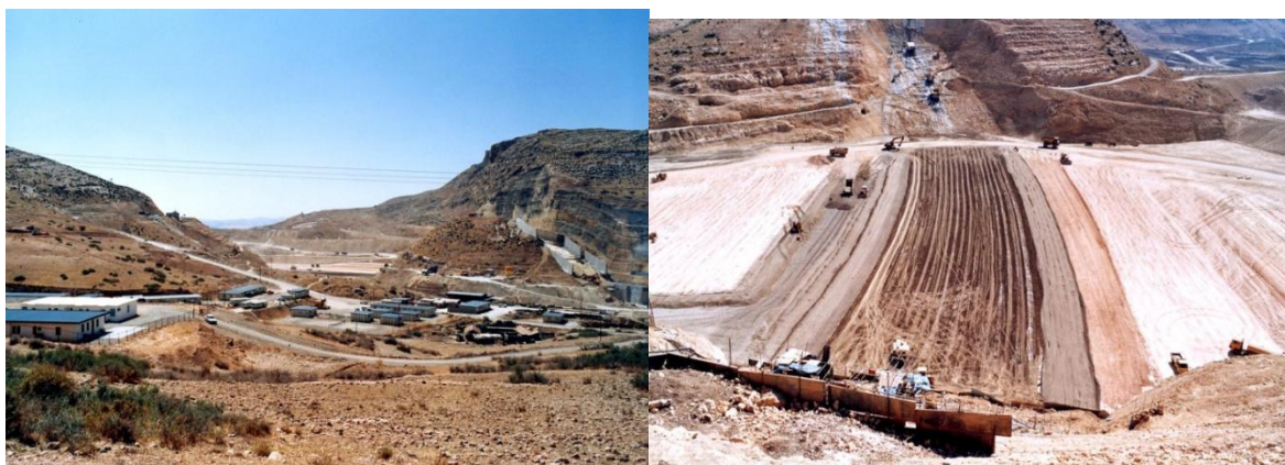
Figure N° II.8 : Construction de la digue de barrage du Gar-Gar
