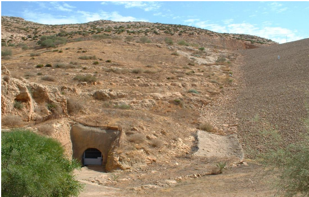
Figure N° II.16: Galerie rive droite (coté 76)
