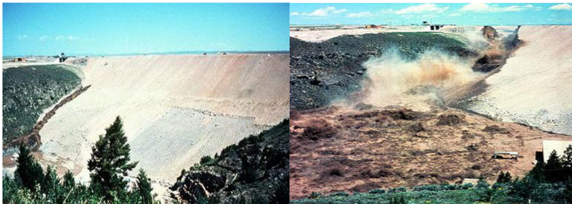
Figure N° I.2 : Barrage de Teton avant et après la rupture
