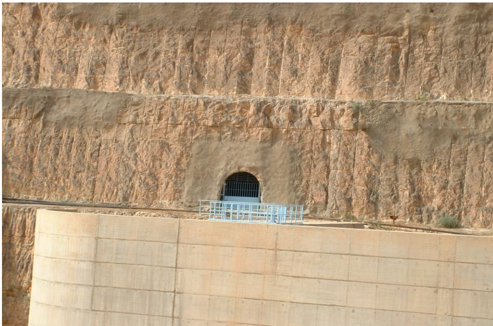
Figure N° II.18. : Galerie d'injection (coté 130)
