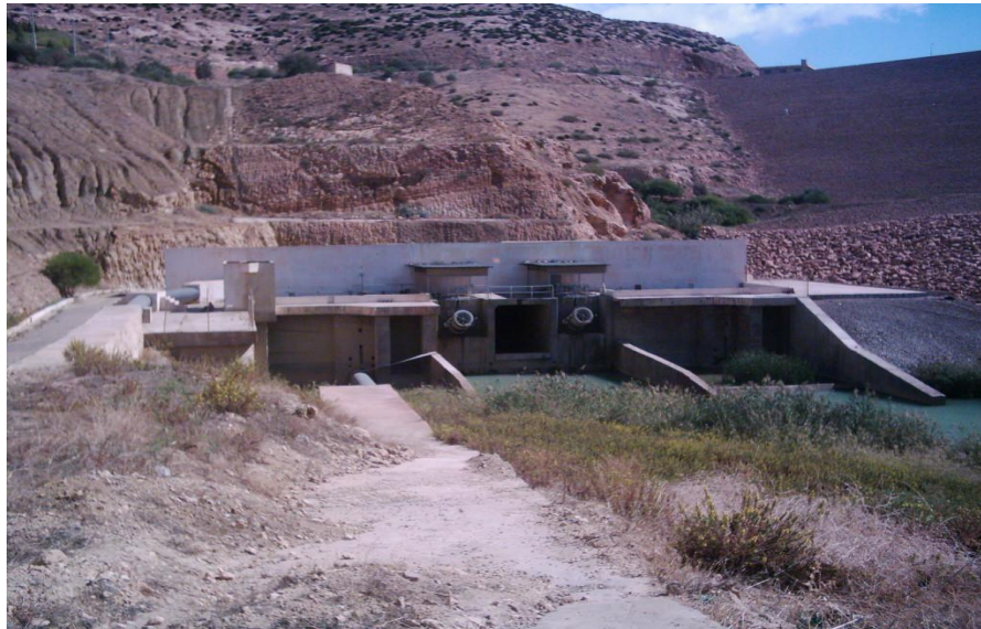
Figure N° III.2 : Ouvrage de sortie
