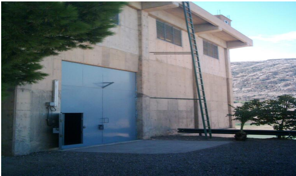
Figure N° II.15 : Puits de prise d'eau
