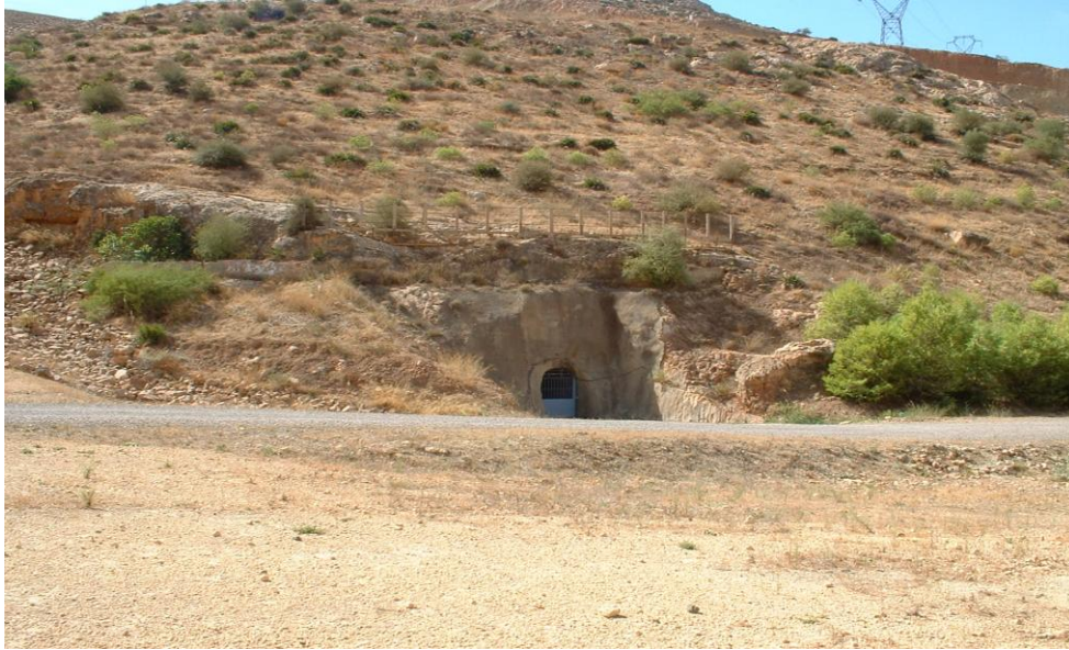
Figure N° II.17. : Galerie rive gauche (coté 79)
