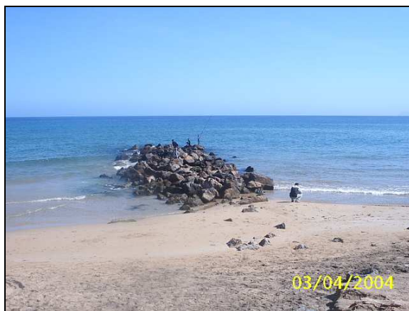
Photo 37 : Epi mal entretenu sur la plage de Bouisville
