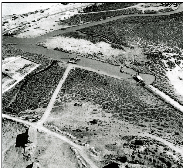
Photo 78 : Travaux de drainage des marais au niveau de l'embouchure de la Macta, (IGN, 1940) Photo 79 : Creusement d'un canal de drainage vers la mer, (IGN, 1940)
