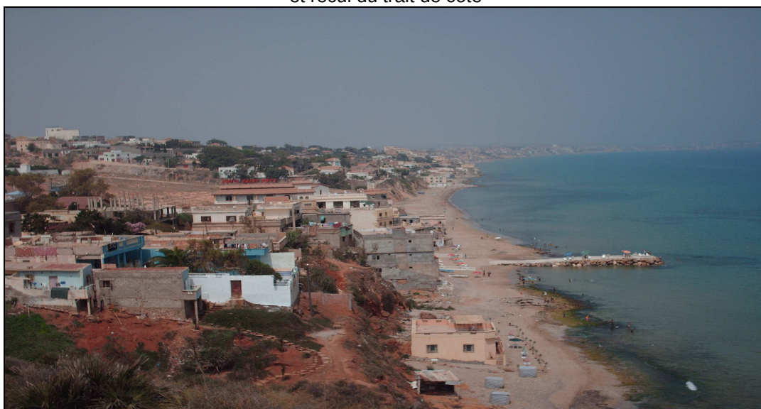
Photo 31 : La plage St Roch par temps calme, été 2006: légère avancée du trait de côte après l'édification d'un épi entrepris par un établissement hôtelier
