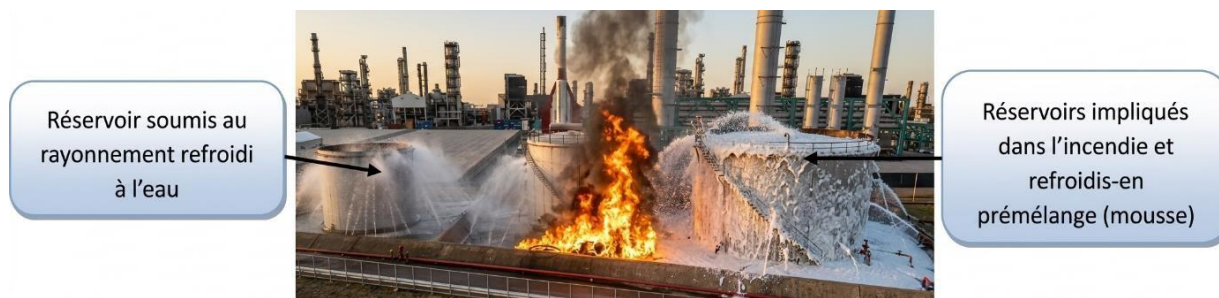
Figure 18: Le refroidissement des réservoirs impliqués
