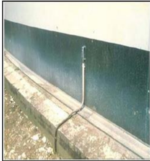
Figure 34: Protection contre la foudre et l'électricité statique
