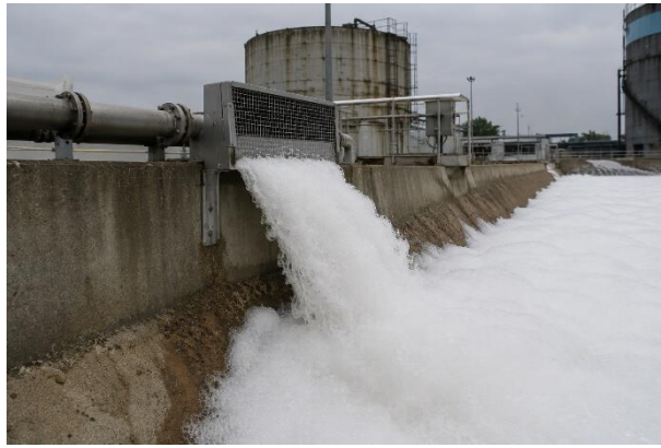
Figure 14: Injection de mousse dans la cuvette.
