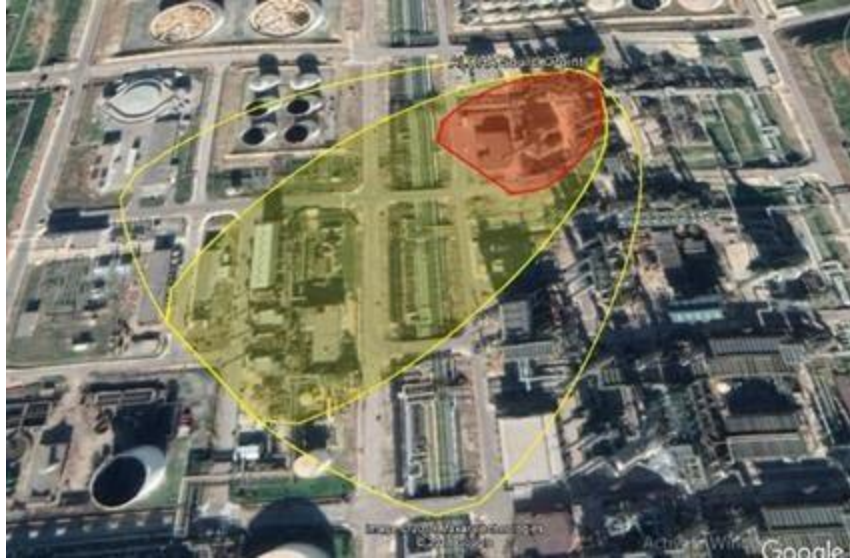
Figure 4: Image de la zone de menace due à l'explosion dans l'accumulateur V-1
