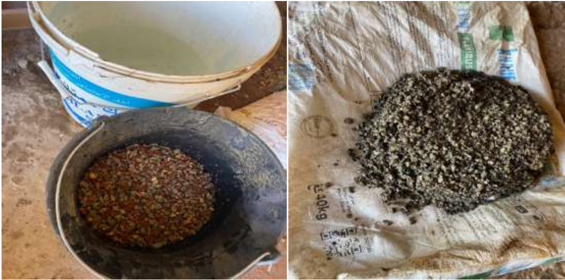
Figure 2.30: Humidification des déblais
