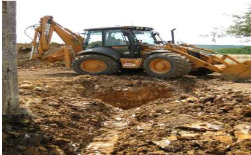
Figure1. 2: les déblais de chantier
