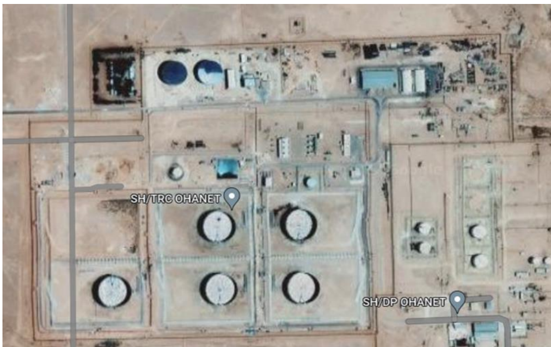
Figure 20 - Vue satellitaire du site SONATRACH RTI – Station de pompage OHANET (SH/TRC et SH/DP), Daïra d'In Amenas, Wilaya d'Illizi
