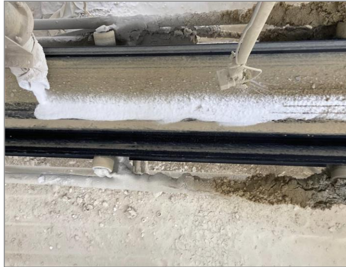
Fig.26 :L'activation avec le carbonate de sodium
