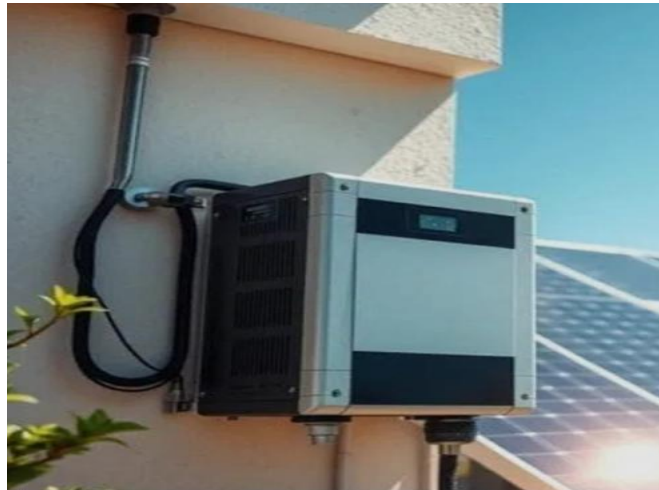
Figure I-12 : Onduleur solaire photovoltaïque
