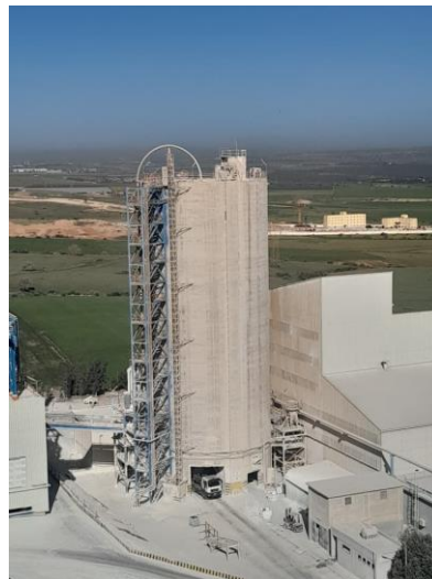
Figure I-10. Silo de stockage de ciment finale
