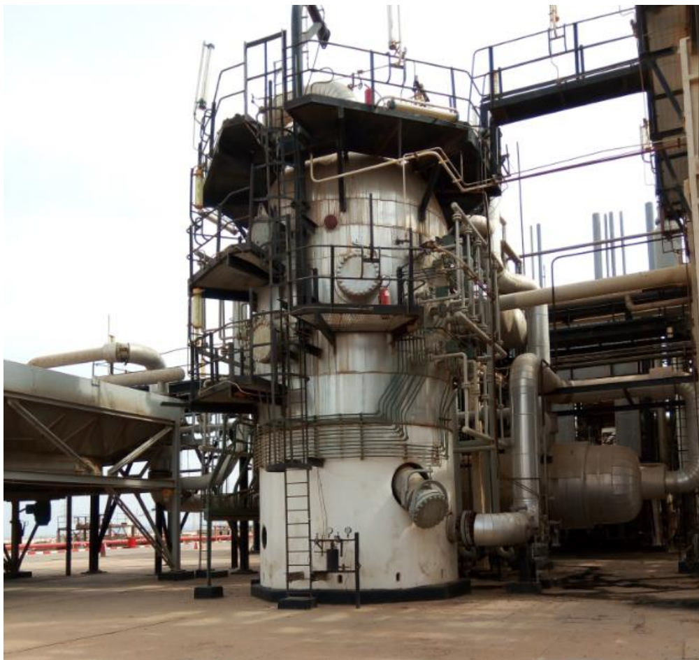
Figure IV-4 Le réacteur V501 de la synthèse de méthanol ( Manuel d’utilisation du méthanol, rapport interne de la société CP1Z, ORAN, ALGÉRIE., 2014 )
