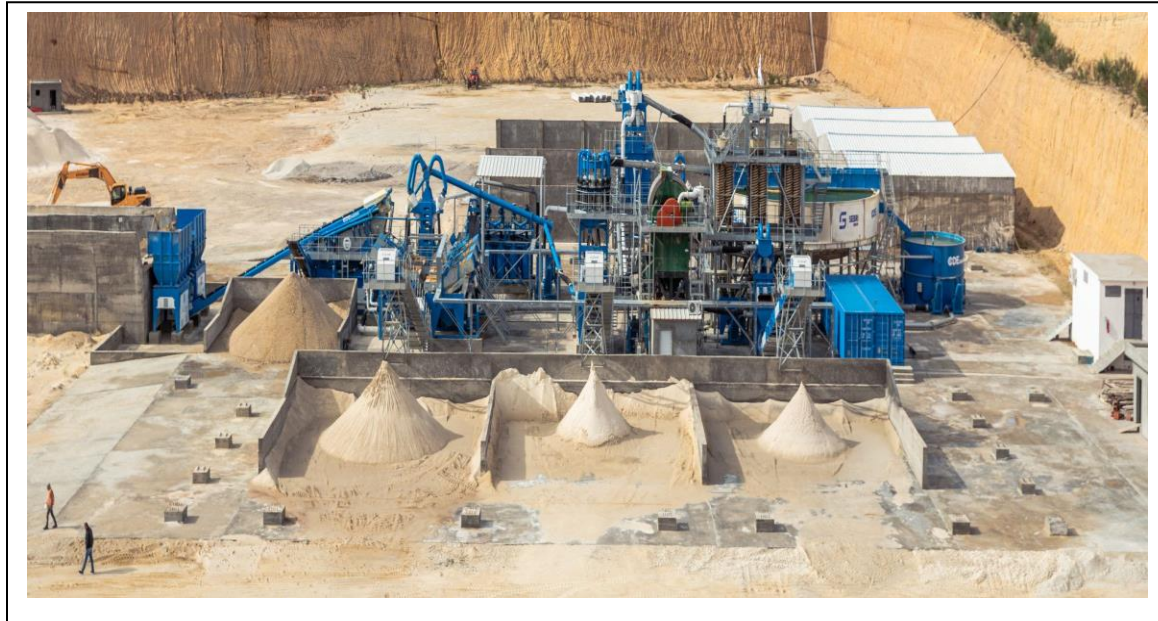
Photo 13: Station du traitement le sable siliceux
