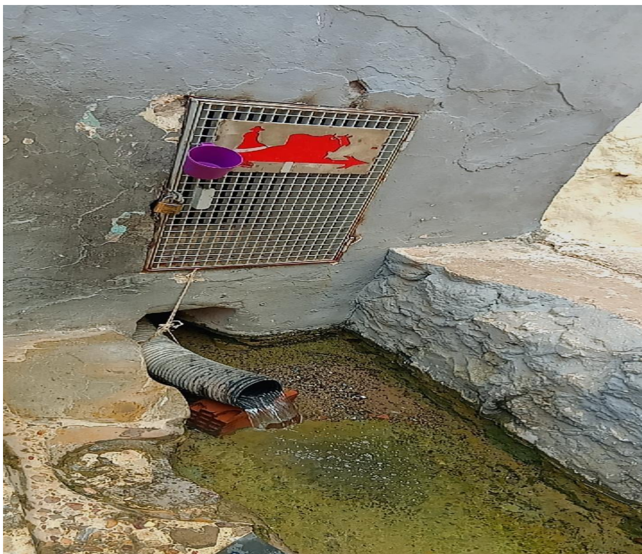
Figure 40 : Nouvelle conduite de captage
